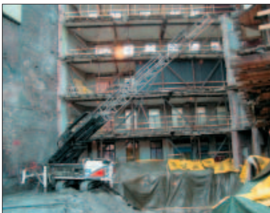
VANN. Jetgrunn 2000 AS ble innkalt for å hindre innstrømming av vann og en reduksjon av poretrykket i byggegroppen.
